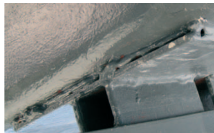
„Geschweißter“ Plattenanschluss an einen Träger
