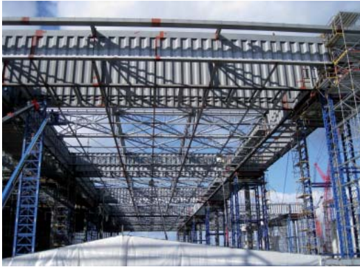
Fluggastterminal im Bau
