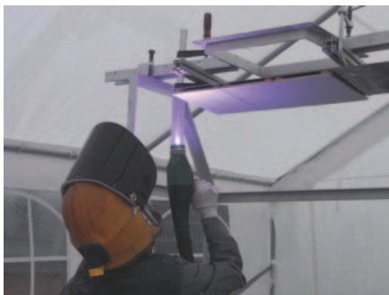
Herstellung thermisch gespritzter Schichten Prozesscharakteristika: Handspritzarbeit, Überkopfspritzposition, unter simulierte Baustellenbedingungen
